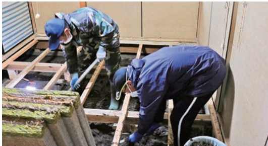
家屋の床を剥がして泥だし 水分を含んだ泥だしは重労働
